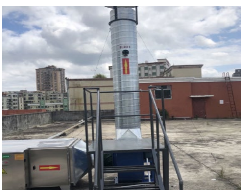
检测口及检测平台
