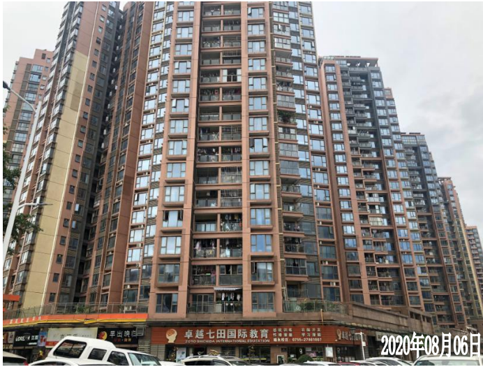
项目西面住宅区
