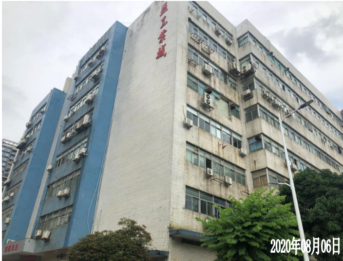
项目厂房外观
